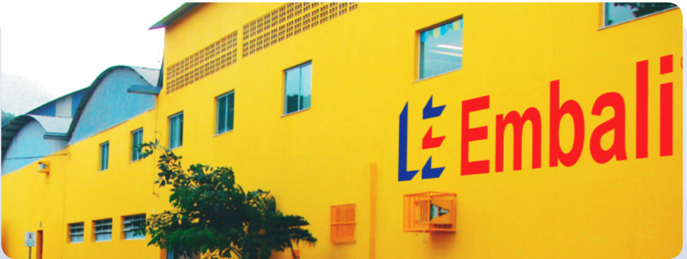
Fachada da Embali
